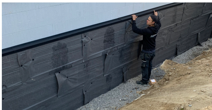
Thermodren monterert på murvegg, med overgangslist på øvre del.
